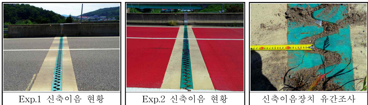
【그림 3.21】 신축이음장치 현황 및 외관조사
