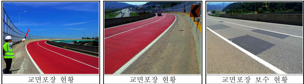
【그림 3.3】 교면포장 현황
