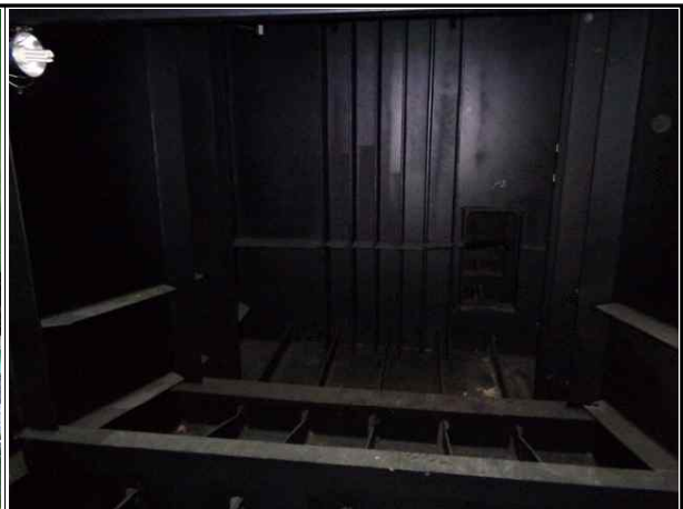
거더 내부 외관조사(도보)
