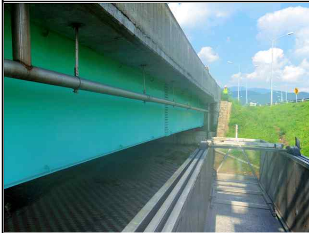
배수관 외관조사(교량점검차, 도보)
