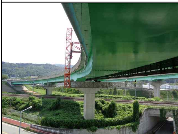
거더외부 외관조사(교량점검차, 도보)
